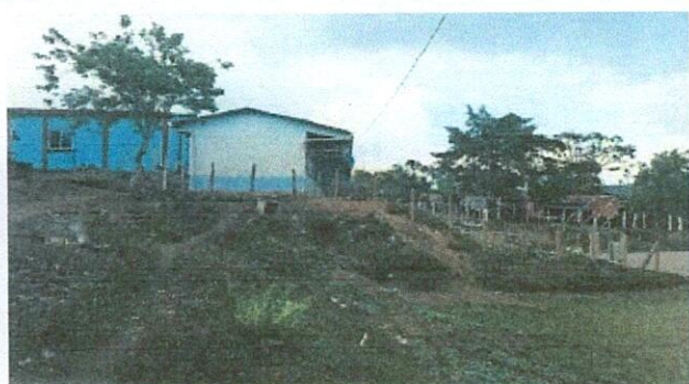
Foto 3: MEJORAMIENTO DE MODULO DE AULAS.
