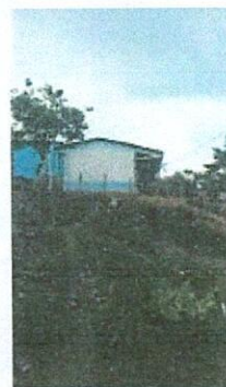
Foto 2: MEJORAMIENTO DE MODULO DE AULAS.
