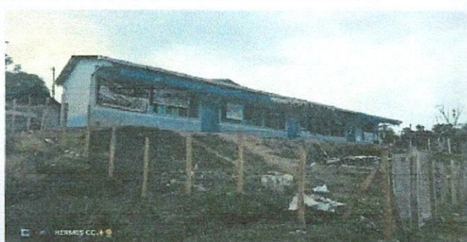
Foto 1: MEJORAMIENTO DE MODULO DE AULAS.
