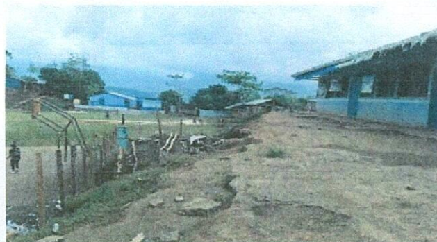
Foto 4: MEJORAMIENTO DE MODULO DE AULAS.
